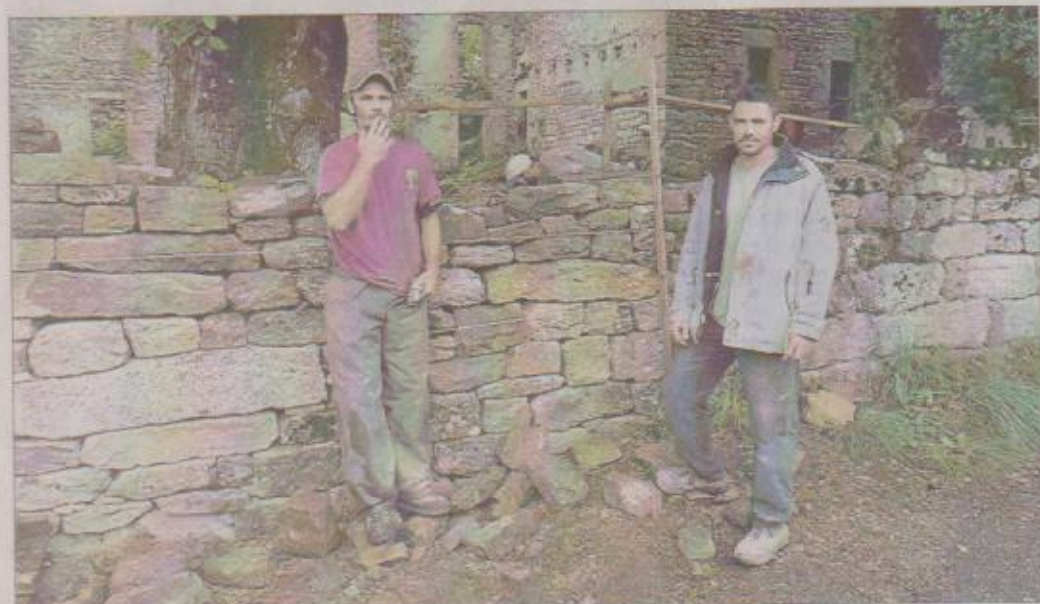
■ Sous la direction de Franck Fabre, les stagiaires montent des murs en granit, sans liant.
